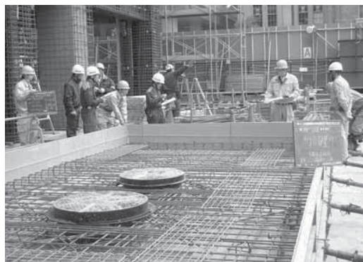
危険物地下タンク貯蔵所中間検査
