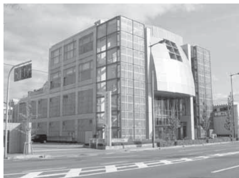
市民防災センター
