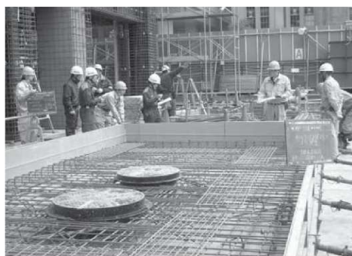
危険物地下タンク貯蔵所の中間検査
