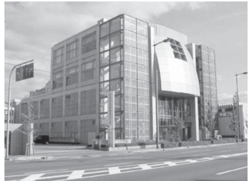
市民防災センター
