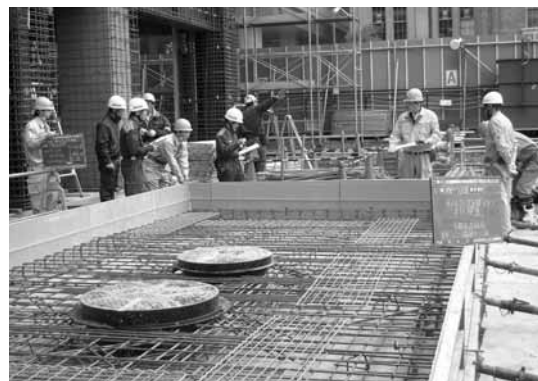
危険物地下タンク貯蔵所の中間検査
