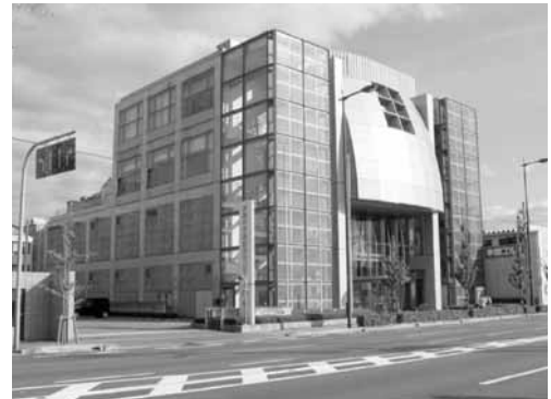
市民防災センター
