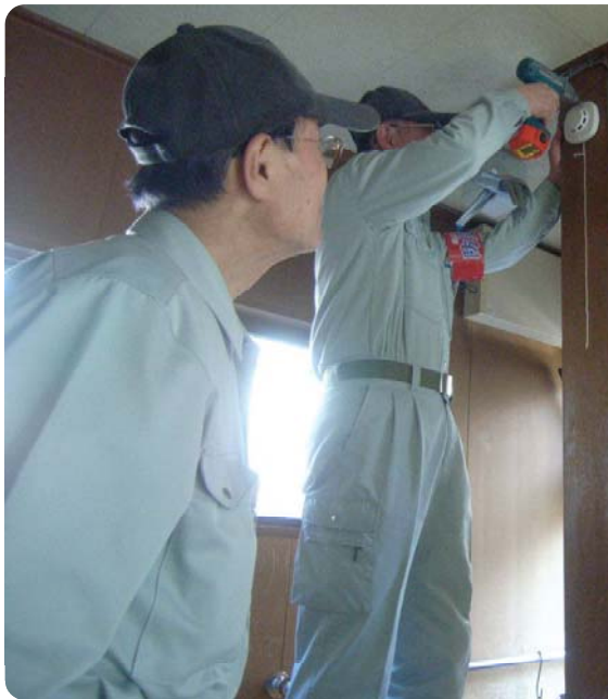
自主防災会本部役員による 住宅用火災警報器設置工事
