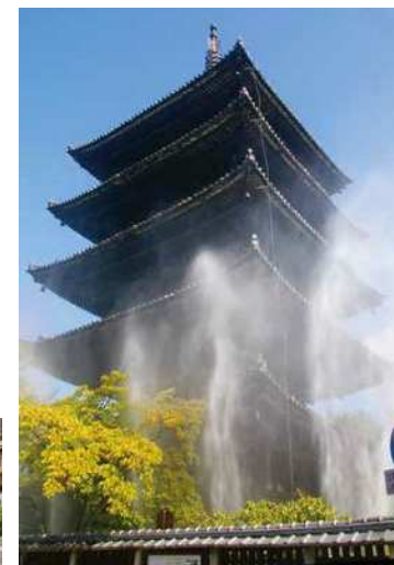
法観寺文化財延焼防止放水システム Water-discharge system to prevent fire from spreading in Hokanji Temple
