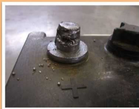
ターミナルの緩みによる損傷
