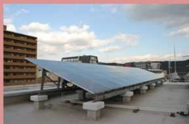
太陽光発電システム
