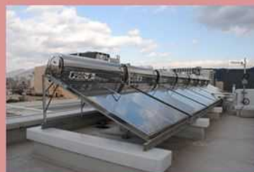
太陽熱利用温水設備
