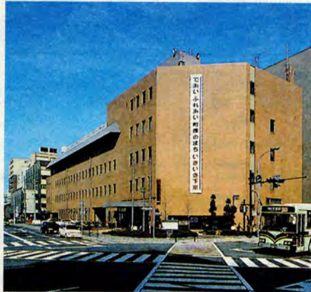
下京区総合庁舎
