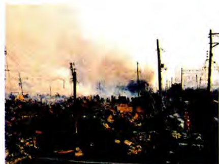
阪神・淡路大震災による被害
