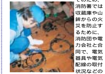
電気配線検査の様子
