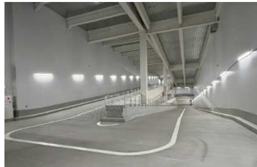
棟内スロープ
