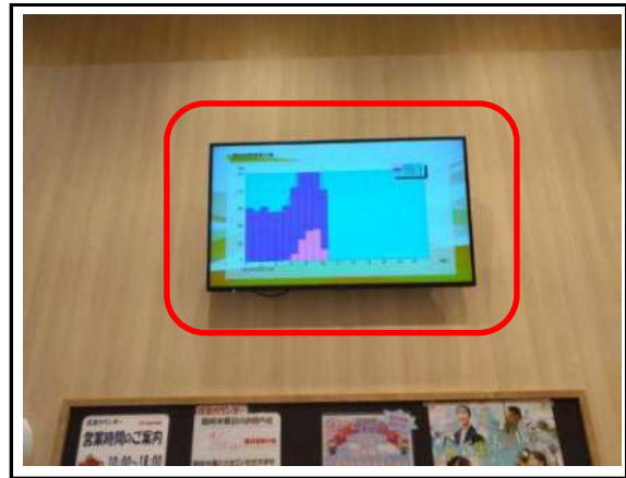
太陽光発電 稼働モニター
