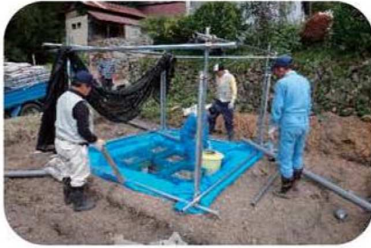
わさび試験栽培地設置作業
