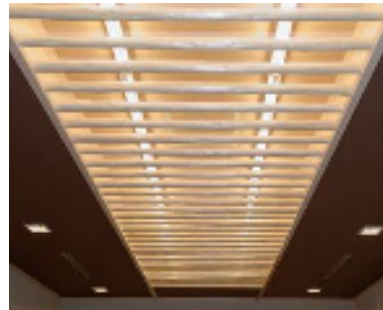
北山タルキを使用した照明意匠 ※撮影場所：京都北山杉の里総合センター
