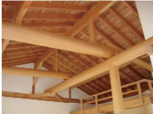
北山磨丸太を構造材として使用した例 ※株式会社竹内工務店提供
