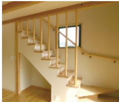
北山タルキを使用した階段 ※株式会社竹内工務店提供
