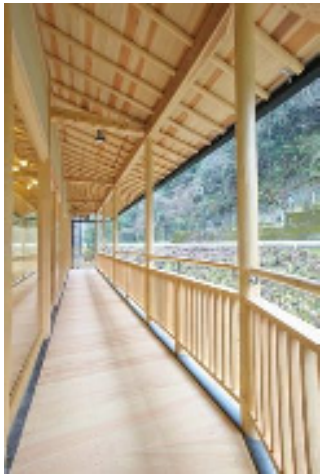
北山磨丸太・北山タルキを使用したテラス ※撮影場所：京都北山杉の里総合センター
