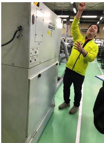
集塵機の装置にもアンカーを打っていたが、 外れて上に持ち上がった時の事を説明中。
