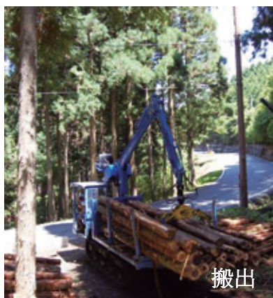
作業路の整備
