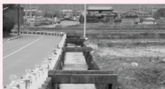
農業用の橋梁（農業用通路橋）
