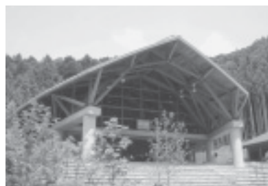
多目的ホール「森愛館」
