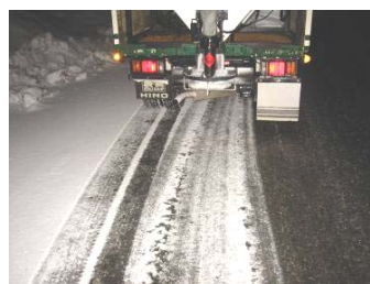
凍結防止剤散布作業
