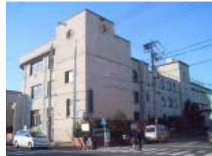
現在の左京区総合庁舎
