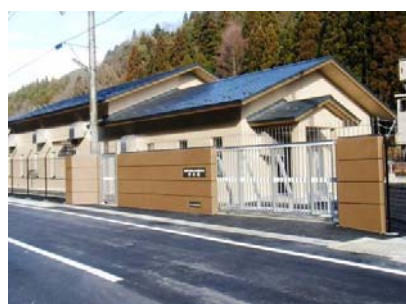
広河原、花脊簡易水道浄水場
