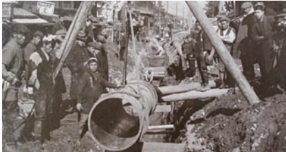
明治44年 配水管敷設工事
