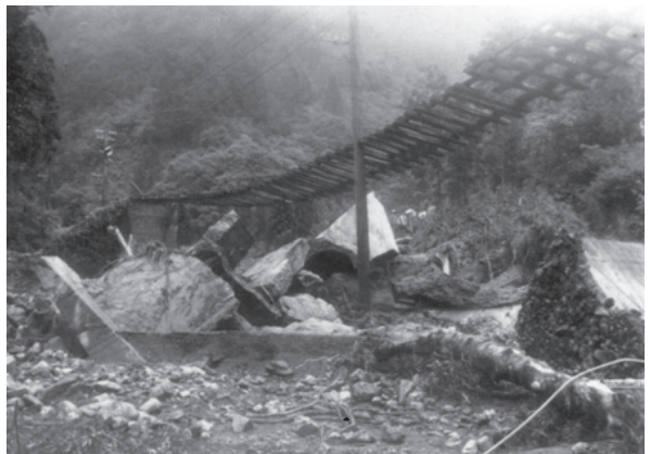
昭和10年6月29日の水害で宙づりになった鞍馬電車の線路(林野庁京都大阪森林管理事務所蔵)
