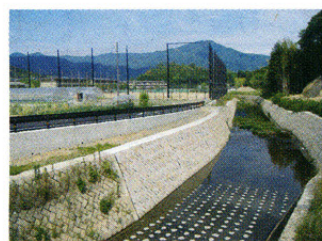
改修した長代川
