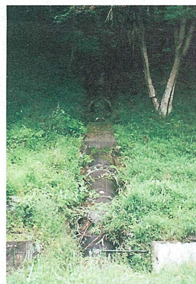
高野水力発電所導水管跡 (平成14年)
