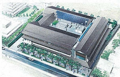
太陽光発電パネルを設置した屋上
