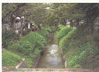
工事により清らかな水流が回復した第二疏水分線
