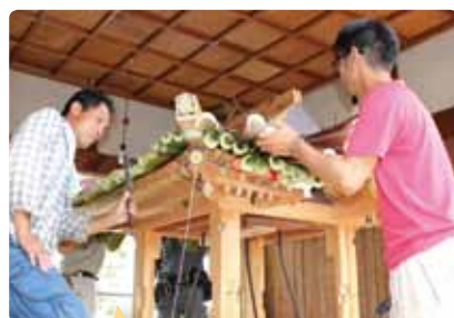
手際よく屋根が葺かれていきます
