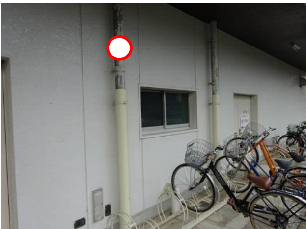
②設置予定箇所（駐輪場の配管）
