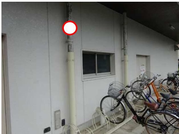
②設置予定箇所（駐輪場の配管）
