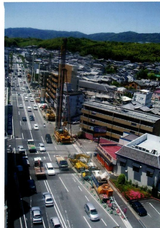
一般国道9号京西立体交差事業 (千代原口交差点付近)
