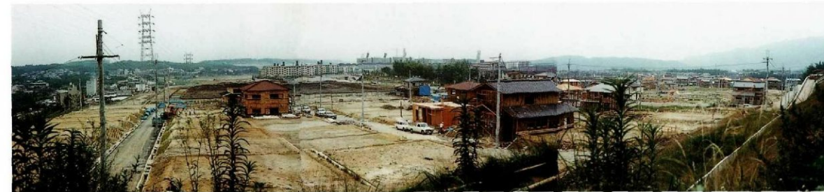
西新林一丁目北部から新林池公園 工事中（昭和52年5月頃）
