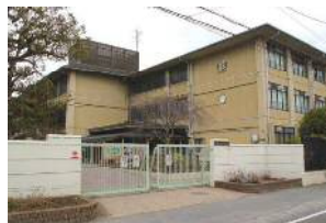
松尾中学校。古墳前期から古墳後期まで栄えた松室遺跡の上に建設された。
