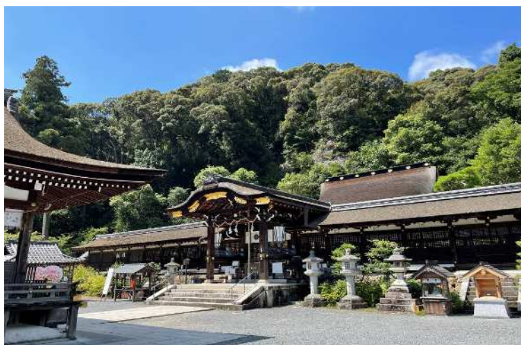
本殿<松尾造り屋根>重要文化財 （写真提供 松尾大社）
