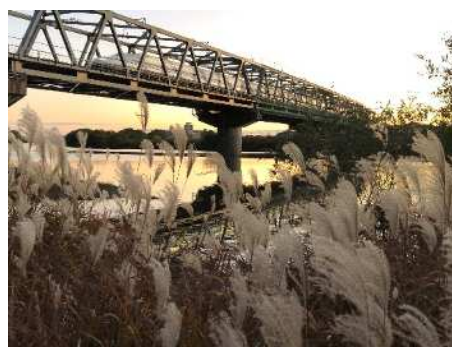
撮影：kitoshin.kamikuze 様 場所：東海道新幹線桂川橋梁
