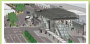
京都駅八条口駅前広場整備
