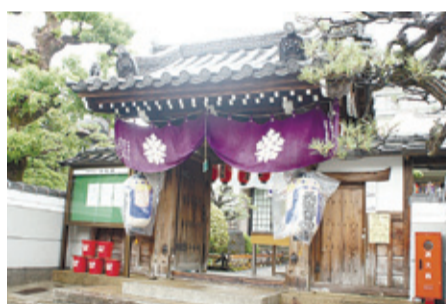
久世西小学校の南側にある荘厳な門と本堂を備えるお寺。この行願寺は寛永6(1629)年に、日空春慶僧都によって創立されたと言われています。当時は一帯がほとんど農地で、檀家数は20〜30軒程度でした。分家等によって家も増え、寺は地域の信仰の中心として発展しました。
