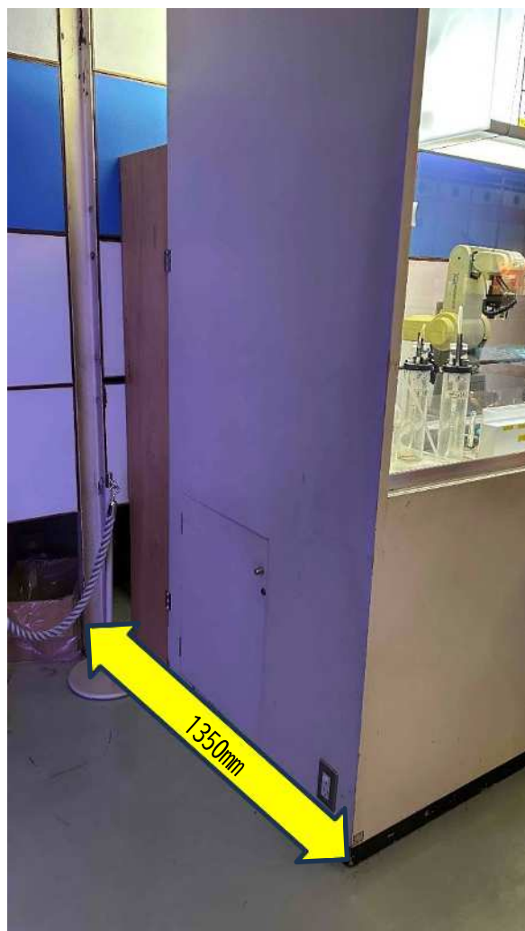
【別紙3 設置場所の現状の様子（北側面）】
