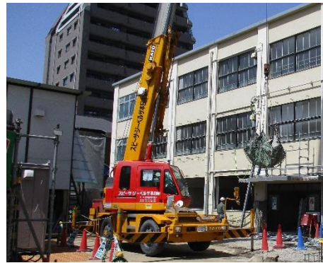
(工事現場の様子)
