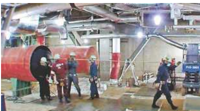
公開された九州電力玄海（げんかい）原発1号機の廃炉作業＝2019年12月、佐賀（さか）県玄海町
