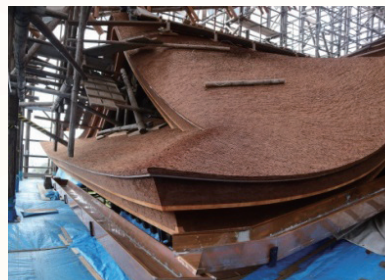
修理中の本堂の屋根
