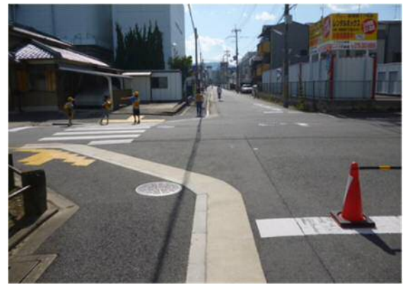
横断歩道設置に伴う歩道の切下げ
