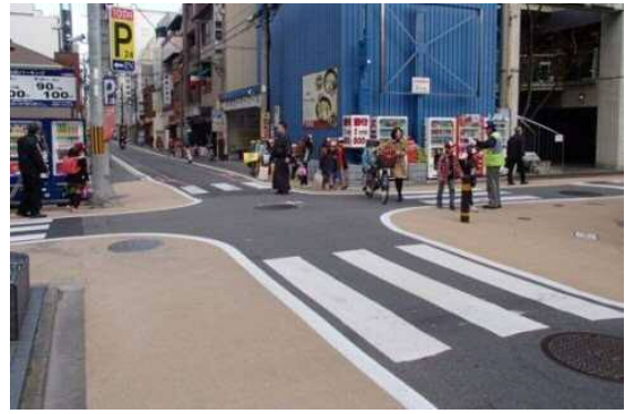
横断歩道設置に伴う歩道の切下げ
