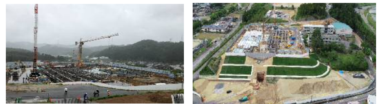
工事現場の様子（5月下旬）
