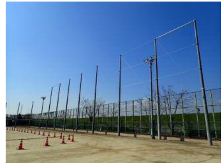
<向島南小学校 防球ネット工事>
