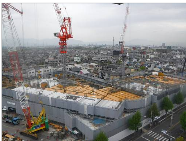
<4月上旬現在の工事現場の様子>
