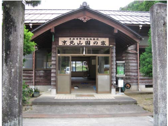
本館(入口) ②
