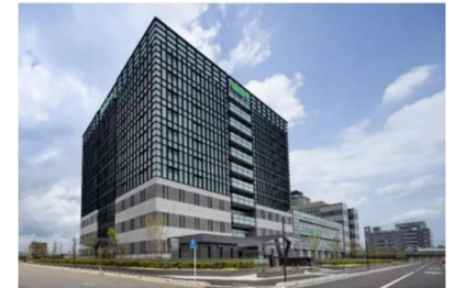
ニデックパーク C棟外観
